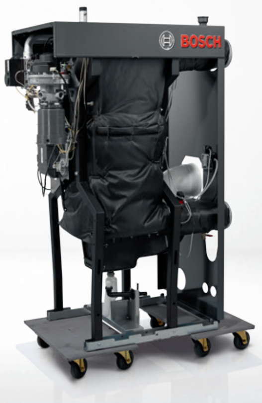
Kocioł Bosch Condens 7000 F w instalacji kaskadowej.
